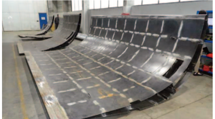
Chantier de remplacement du premier coude de la soufflerie S1MA.
