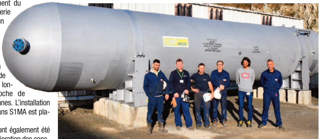
Nouveau réservoir d'air HP du DSMA.
