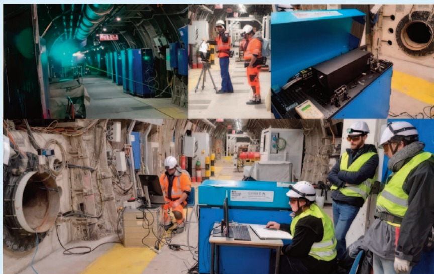
En haut de gauche à droite : alignement du système d'émission/réception avec le pointeur vert, miroir de renvoi du faisceau et lidar positionné pour tirer dans l'alvéole. En bas : équipes ONERA-Andra
