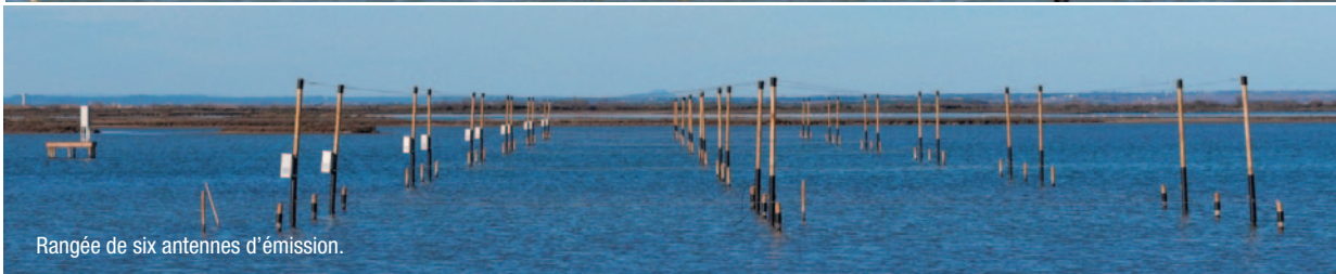
Antennes de réception du ROS salins avec coffret solaire.
