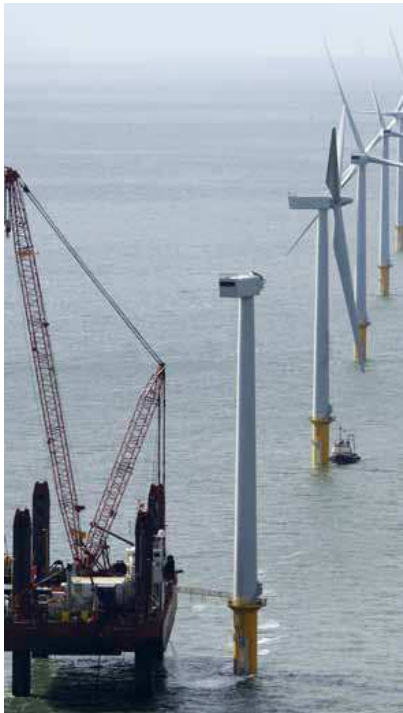
Siemens SWT 2.3 MW SWT 3.6 MW
