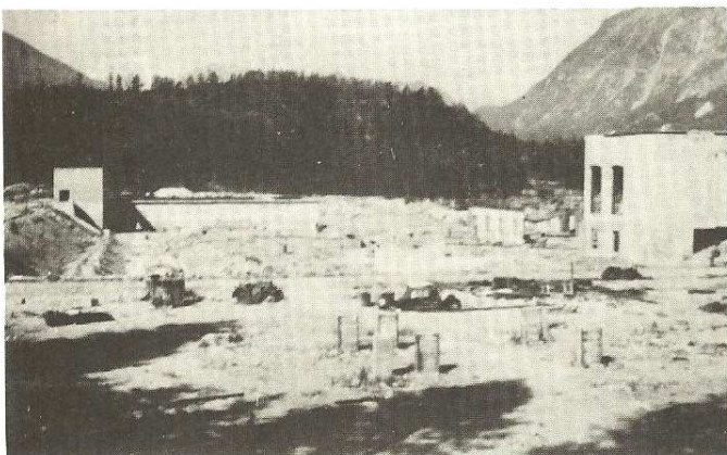
Fig. 4. Chantier d'Ötztal (juin 1946).
